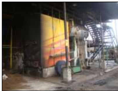
Gráfico N° 3.31 Caldera Acuopitorubular – 250 BHP
