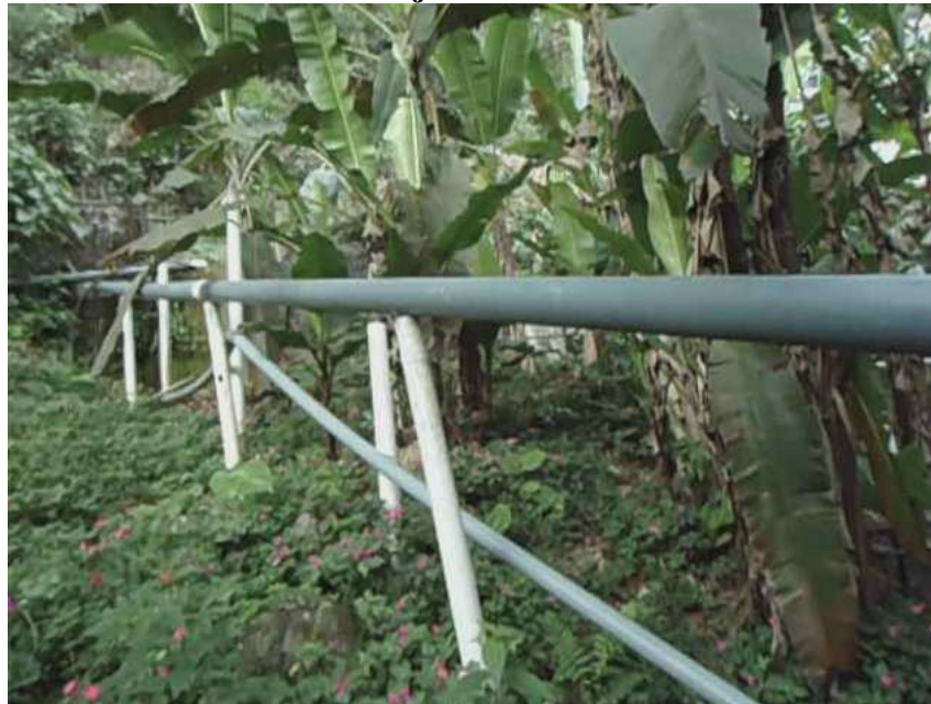
Figura 4-5 Montaje de Tuberías
