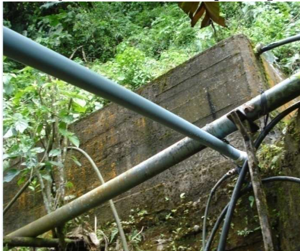
Figura 4-3 Montaje de Tubería en el tanque de agua
