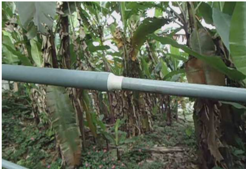
Figura 4-4 Instalación de reducción de tubería
