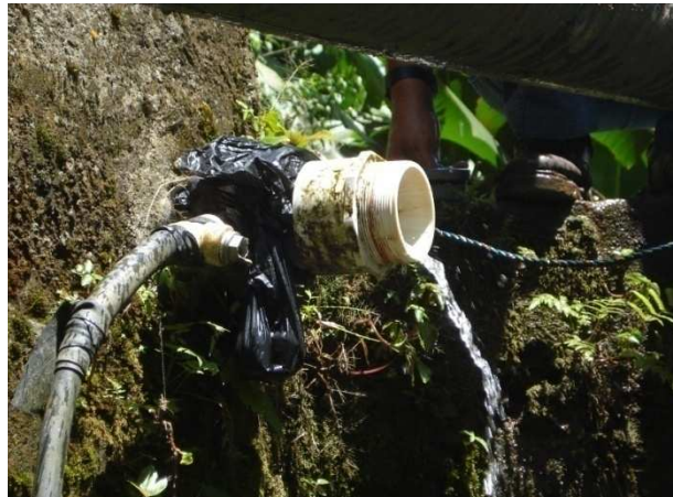
Figura 4-2 Instalación de neplo en el tanque
