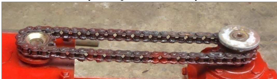
Figura 4-18 Instalación y montaje de las catalinas y la cadena
