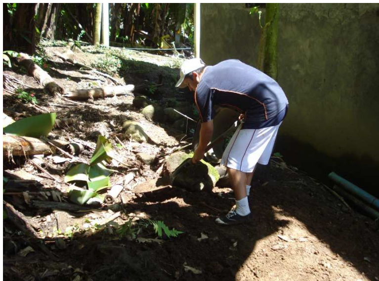
Figura 4-1 Limpieza del terreno
