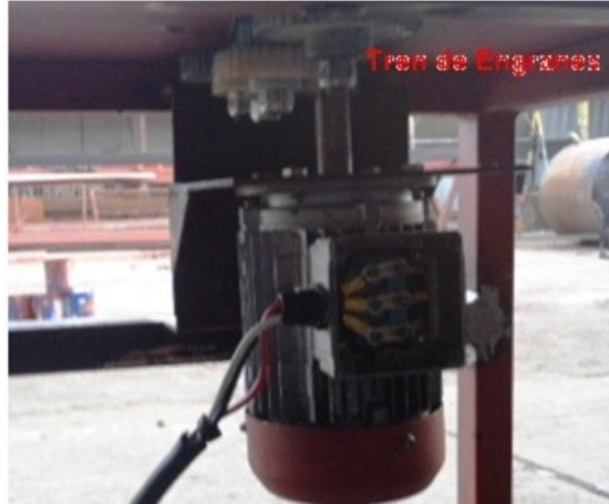
IMAGEN 4.72 MONTAJE MOTORES DE ELEVACIÓN
