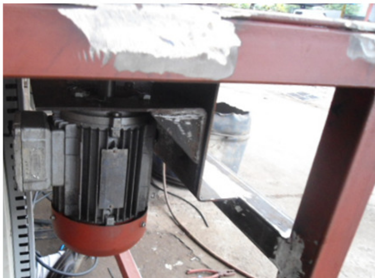
IMAGEN 4.47 INSTALACIÓN DE MOTOR TRIFÁSICO EN ESTRUCTURA
