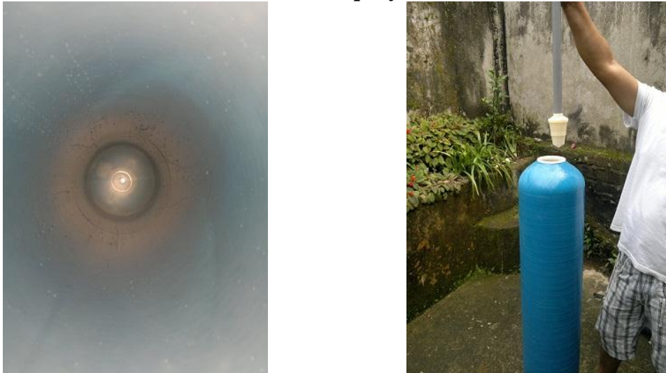
Figura 4.9 Cavidad en el fondo del tanque y colocación del ducto
