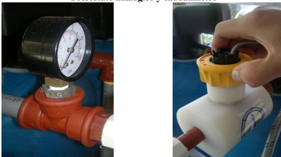
Figura 4.26 Presostato analógico y caudalímetro
