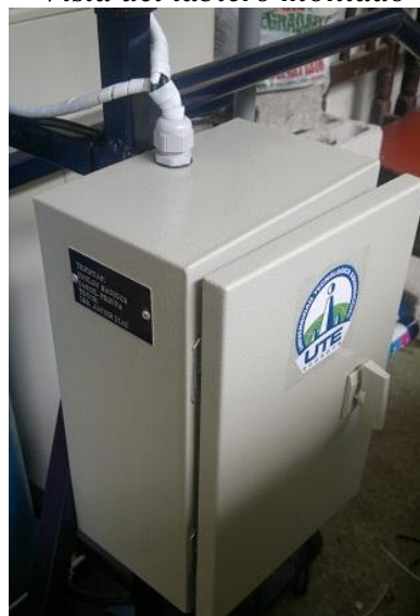
Figura 4.35 Vista del tablero montado
