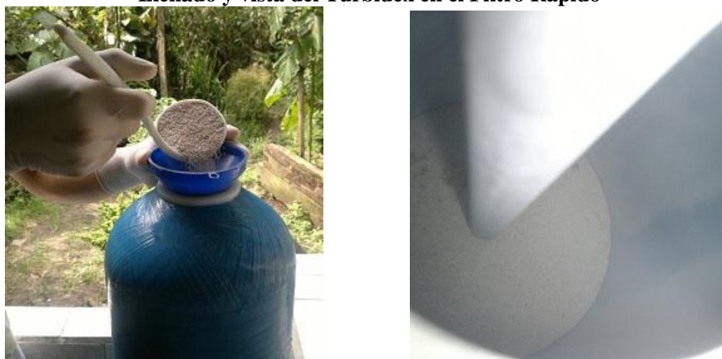
Figura 4.16 Llenado y vista del Turbidex en el Filtro Rápido
