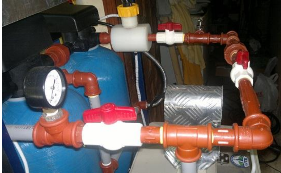
Figura 4.28 Armado total del bypass
