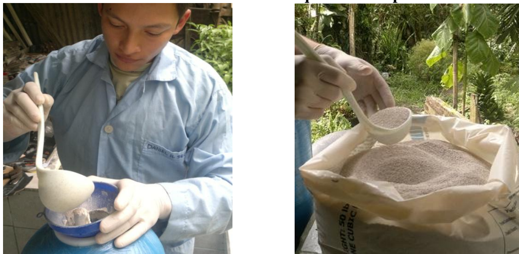
Figura 4.15 Llenado de Turbidex al tanque Filtro Rápido
