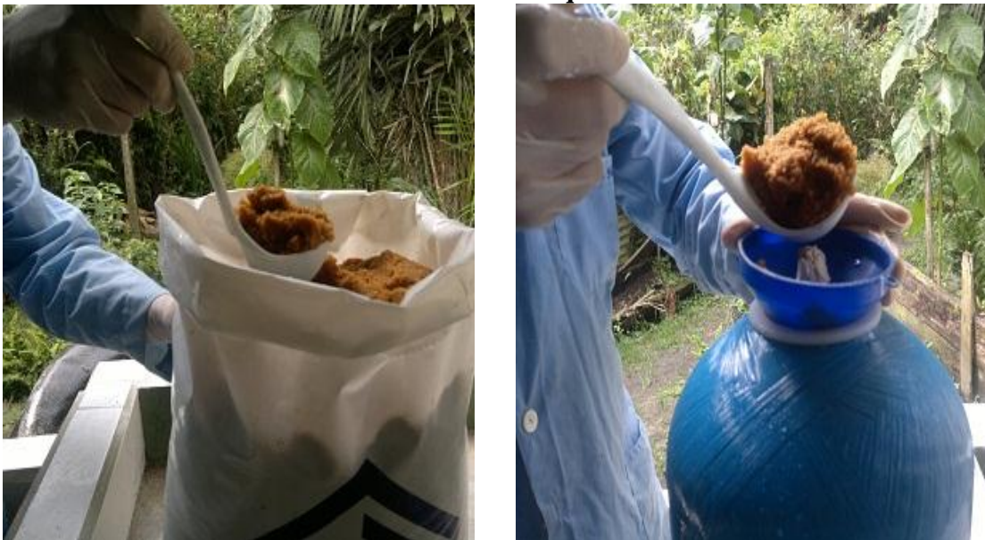
Figura 4.18 Llenado de Purolite al tanque Ablandador
