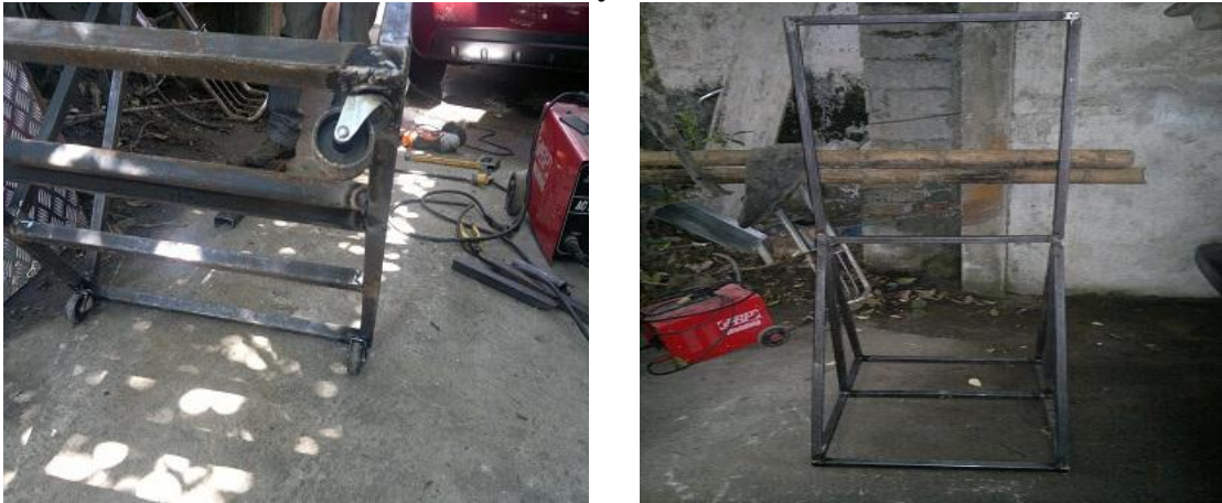
Figura 4.3 Ruedas soldadas y estructura soldada
