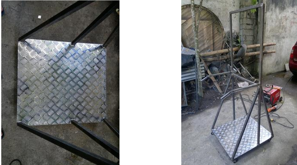
Figura 4.5 Base colocada y estructura libre de asperezas
