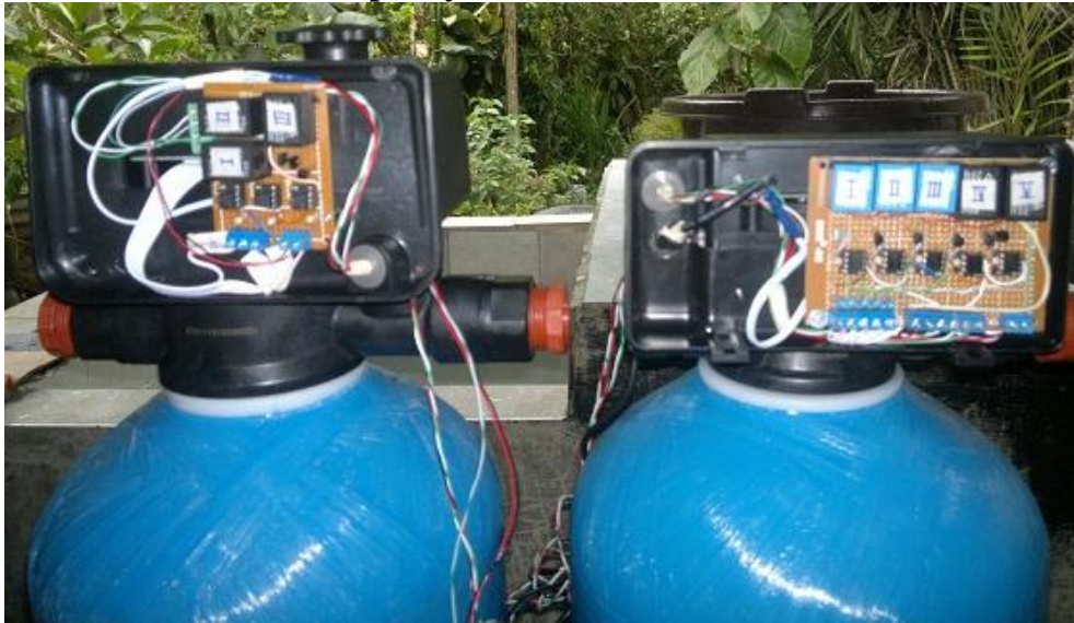
Figura 4.34 Vista del Filtro Rápido y Ablandador con sus cabezales listos
