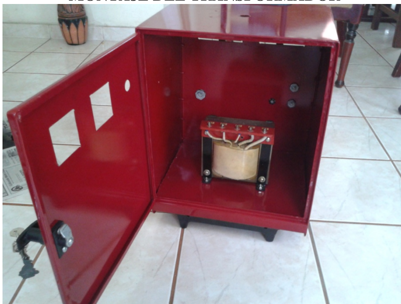
FIGURA 5-10 MONTAJE DEL TRANSFORMADOR
