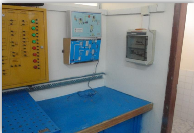
Figura 4.1 Espacio de instalación del módulo
