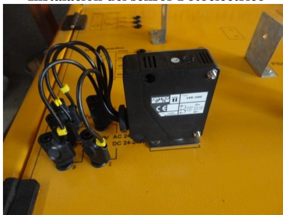
Figura 4.118 Instalación del sensor Fotoeléctrico
