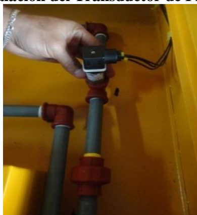
Figura 4.108 Instalación del Transductor de Presión
