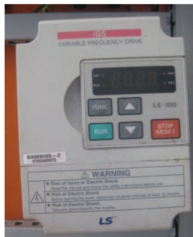
Figura 5-21: Variador de frecuencia
