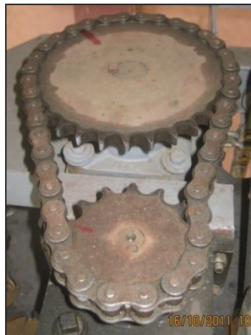
Figura 5-10: Instalación de las Catalinas
