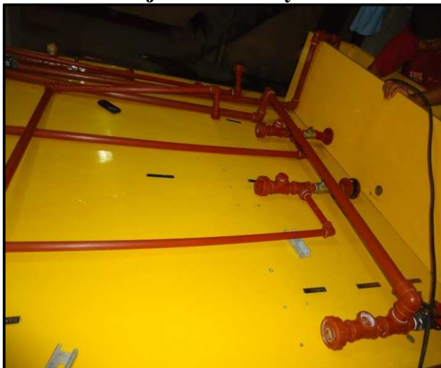
Figura. 4.2 Desmontaje de tuberías y accesorios
