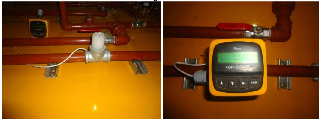
Figura. 4.10 Montaje caudalímetro
