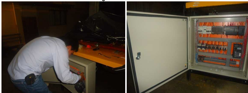
Figura. 4.14 Ensamblaje del tablero de control
