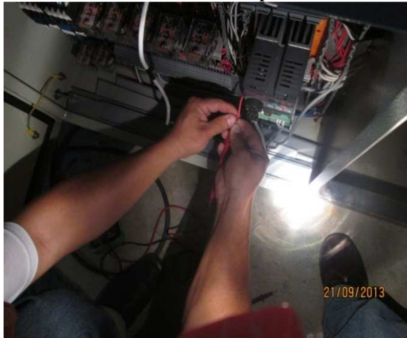
Figura. 3.10 Conexión en serie del amperímetro
