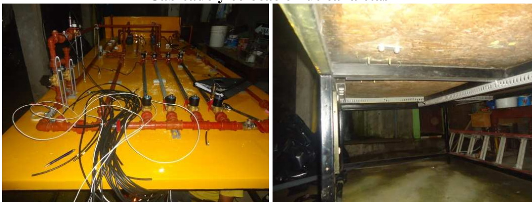
Figura. 4.9 Cableado y colocación de canaletas
