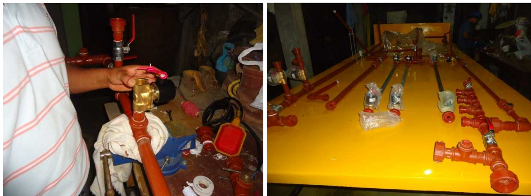
Figura. 4.8 Instalación de electroválvulas
