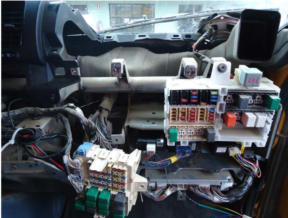
Gabinete de Fusibles
