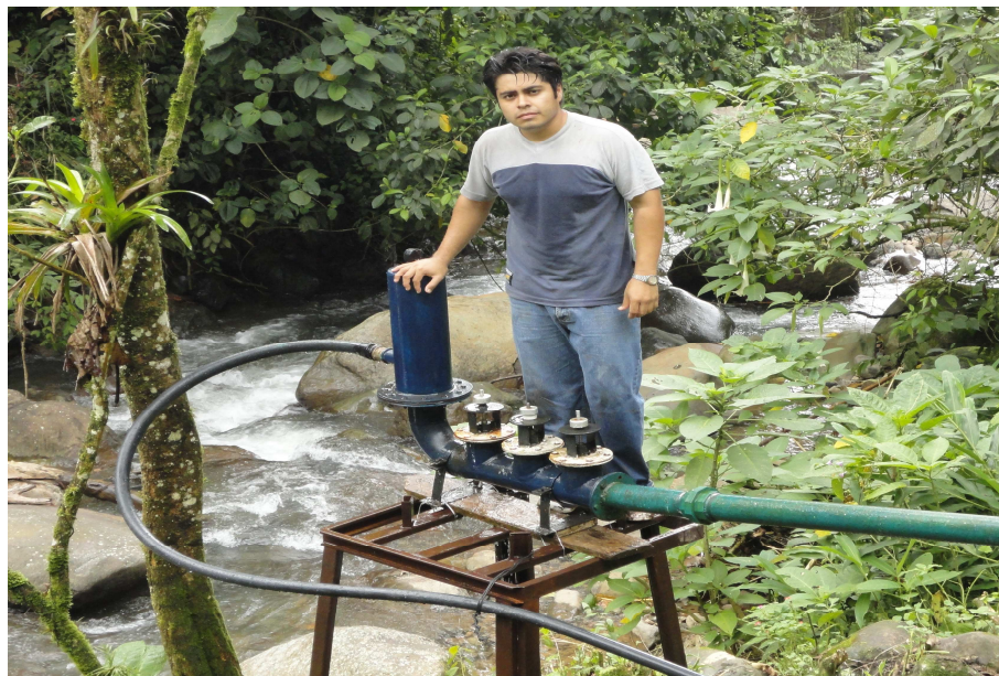
FotoN° 13. MONTAJE EN EL LUGAR DE FUNCIONAMIENTO.
