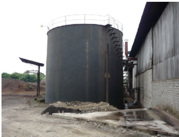
Fig. 1.12 Tanque de almacenamiento de aceite.
