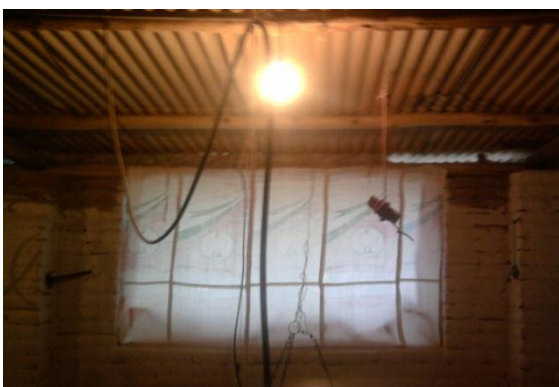
Colocación de luz, cortinas e instalación de agua
