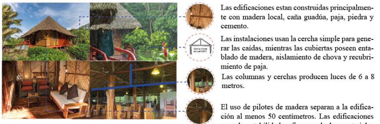
Figura 20: Estructura Napo Cultural Center
