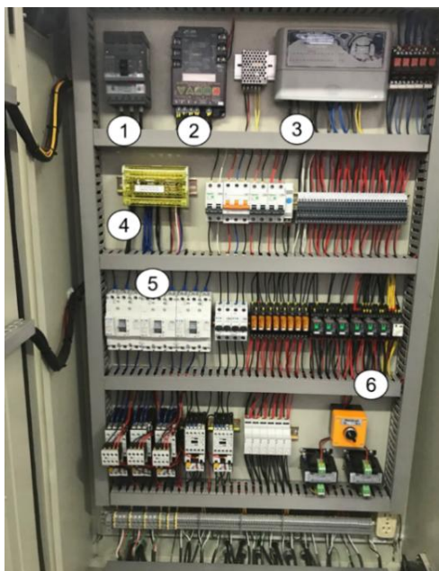
Figura 25. Circuito de control
