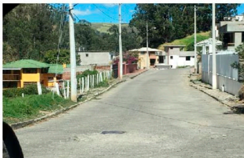
VÍA 2 TRAMO DE ACCESO 3
