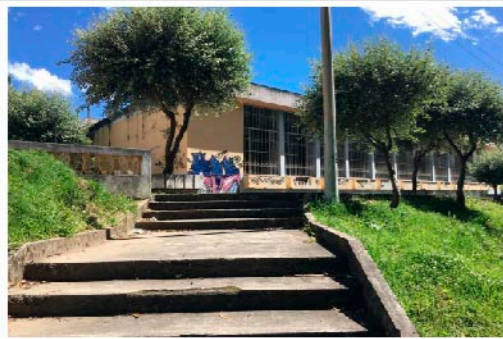
PISCINA Y ESCALINATAS
