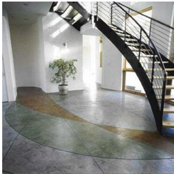
Ilustración 37 Losas de hormigón pulido
