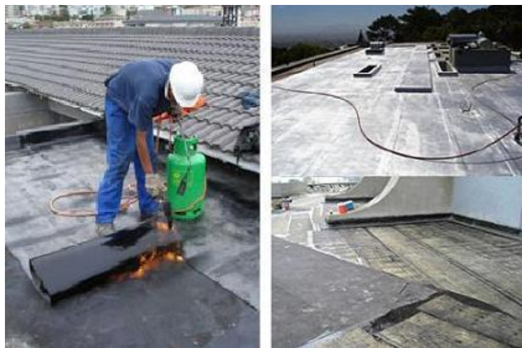
Ilustración 38 Impermeabilización de losa
