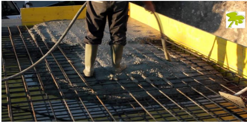
Ilustración 29 Losas de hormigón armado
