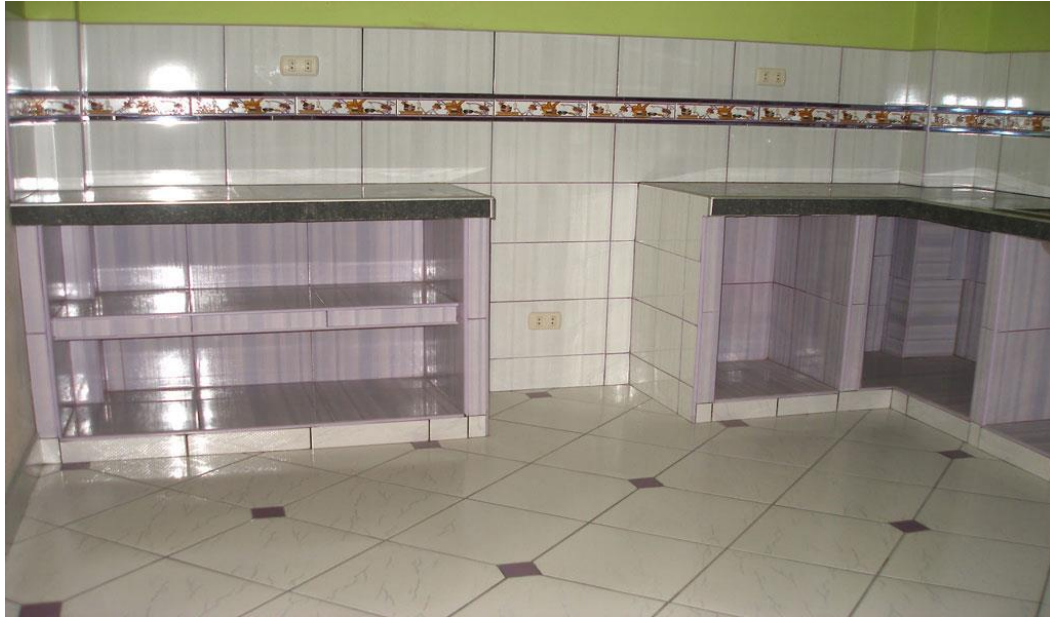
Ilustración 36 Enchape de paredes y pisos
