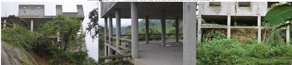
Imagen 49: Vistas de la construcción actual 1
