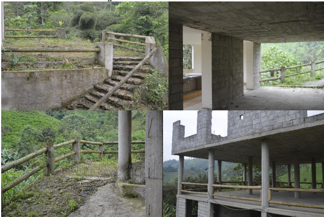
Imagen 50: Vistas de la construcción actual 2
