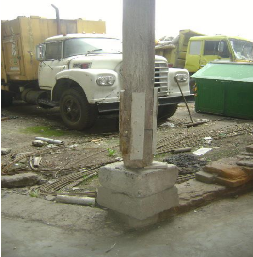
IMAGEN 30. Pilas de pórtico de corredor
