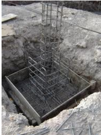
Figura 155. SISTEMA DE CIMENTACIÓN AISLADA EN OBRA.
