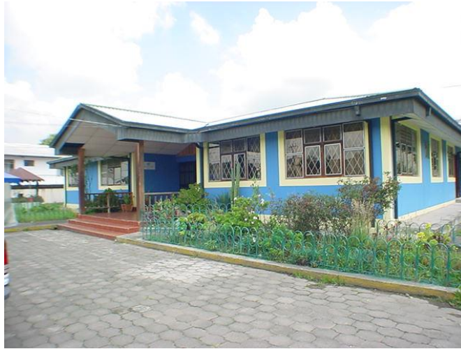
Fotografía N° 11: Salón Comunal Aldea SOS FUENTE: ALDEA SOS AUTOR: ALDEA SOS
