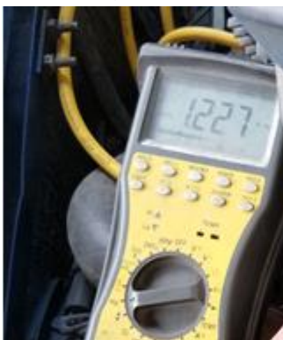
Figura 34. Utilización del multímetro
