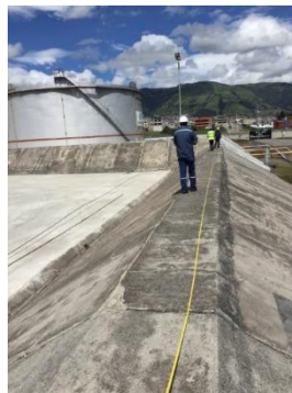
Figura 26. Toma de medidas para canaletas porta-cables.
