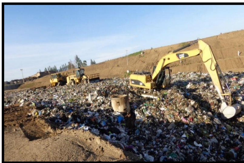
Gráfico 21. Conformación, tendido de residuos
