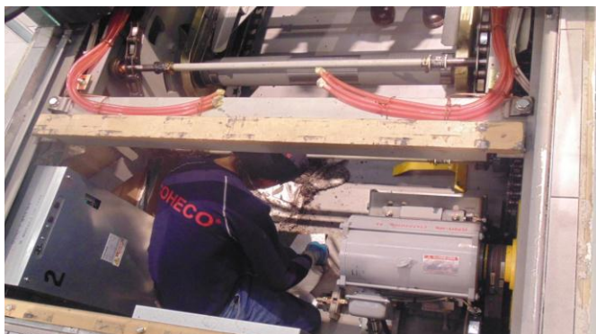
Figura 58. Limpieza de platea. Elaborado por: el autor (2015)
