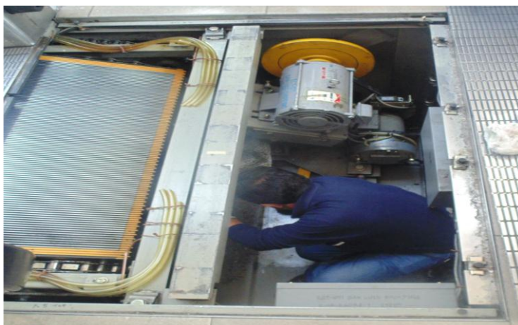
Figura 72. Limpieza de platea superior e inferior. Elaborado por: el autor (2015)
