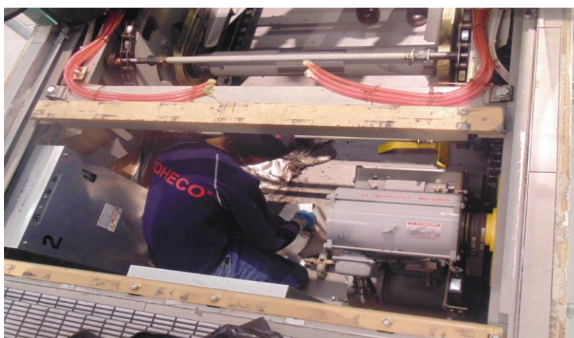
Figura 19. Limpieza de platea. Elaborado por: el autor (2015)
