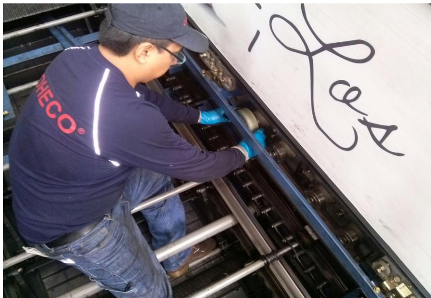
Figura 18. Revisión del conjunto de arrastre. Elaborado por: el autor (2015)
