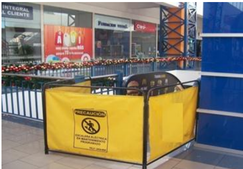
Figura 8. Señalética instalada antes del mantenimiento Elaborado por: el autor (2015).
