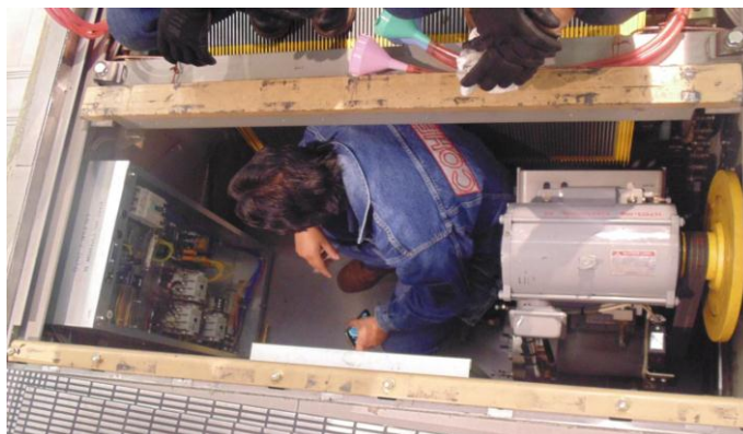
Figura 56. Mantenimiento contactores y control Elaborado por: el autor (2015)
