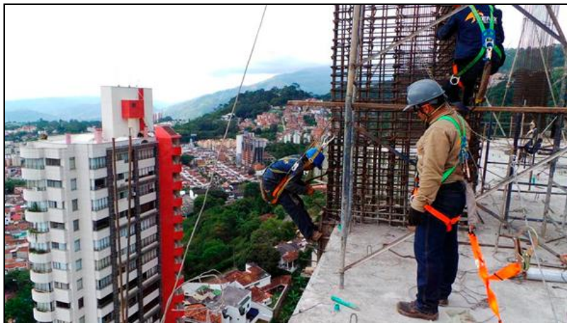
Figura 10. Trabajo en altura en construcción
