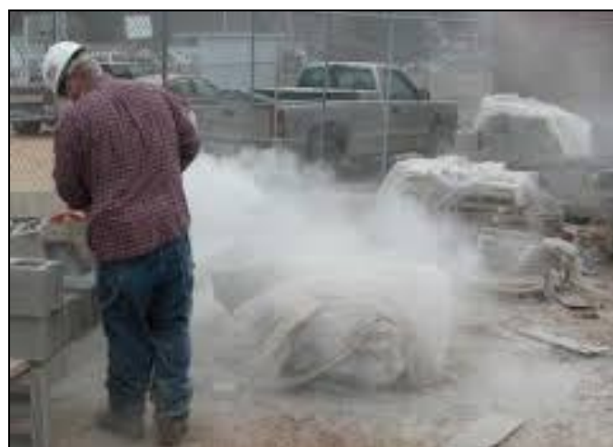
Figura 3. Exposición a polvo por corte de bloques de cemento
