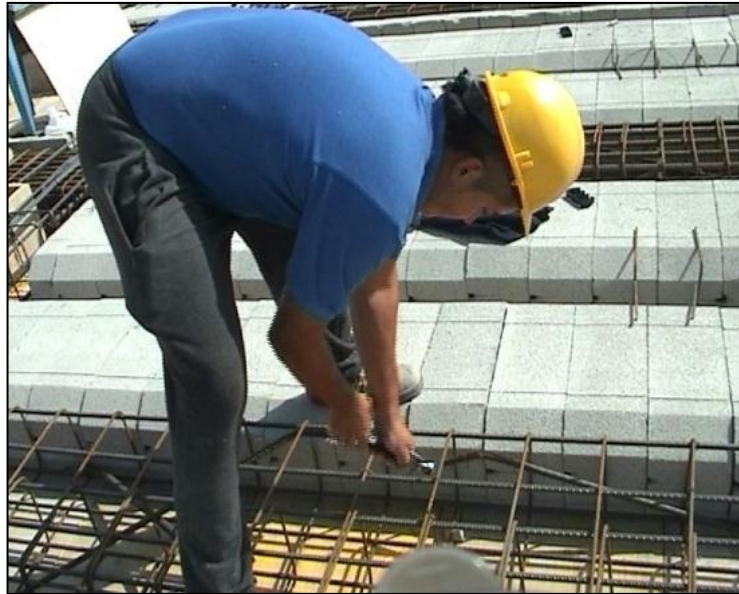
Figura 6. Exposición a posturas forzadas, sobre esfuerzo físico y movimientos repetitivos al armar la estructura de la losa
