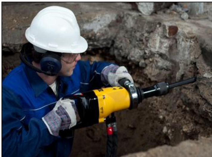
Figura 1. Exposición a ruido y vibraciones por uso de rotomartillo
