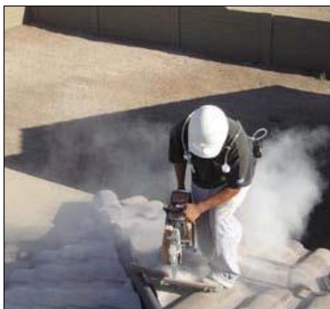
Figura 2. Exposición a polvo por corte de tejas
