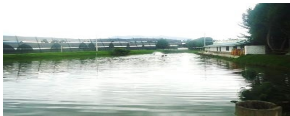
Figura 33 Área del reservorio y casetas de riego
