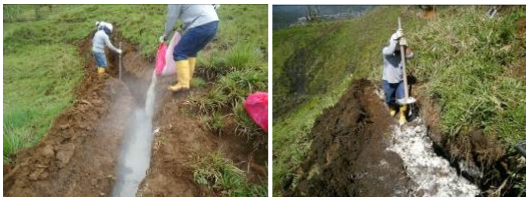
Gráfico 4.13.- Sellado de Fisuras
