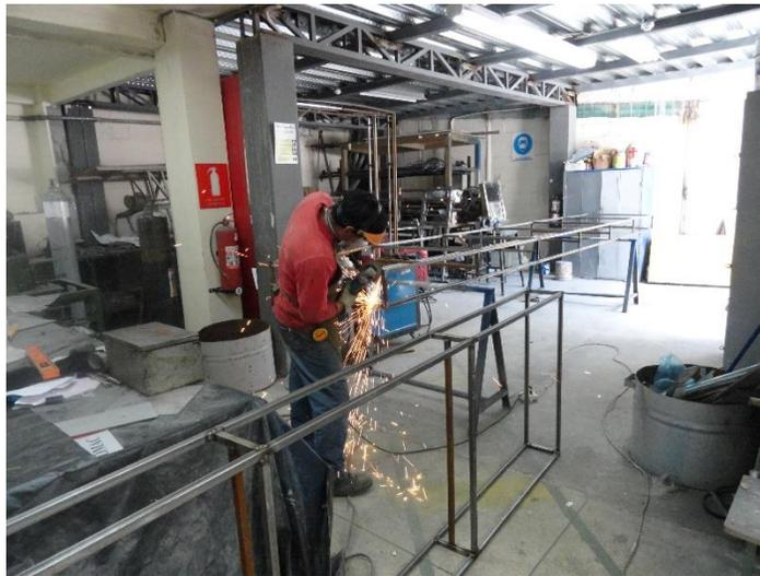
**Fotografía N° 5 Soldadura de perfiles**
