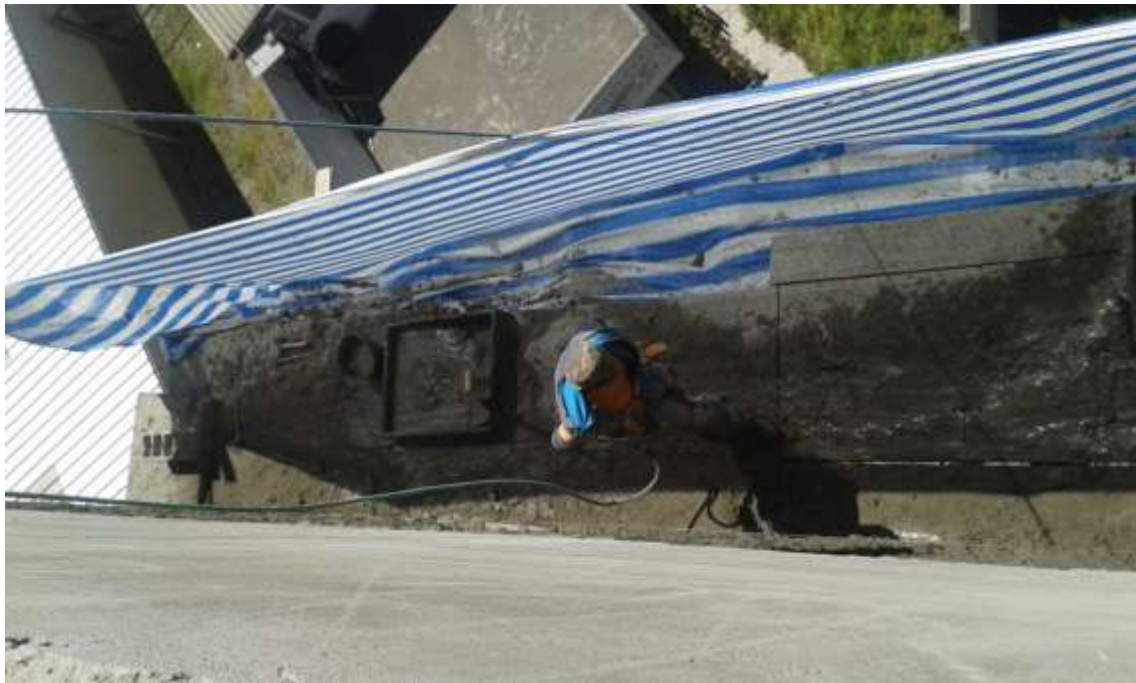
FOTOGRAFIA N° 11: Hombre Albañil realizando tareas de enlucido en exterior y en altura (albañilería) Foto tomada por: William Jácome Terán
