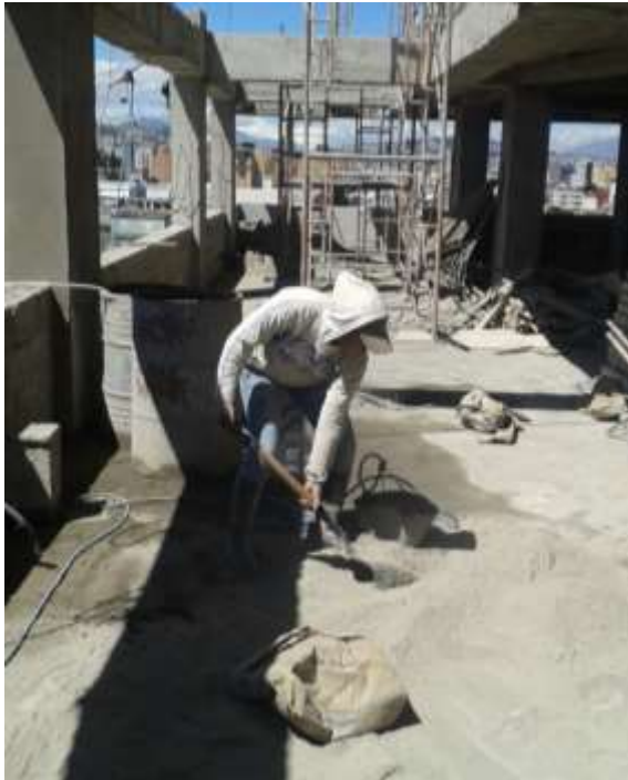
FOTOGRAFIA N° 14: Mujer peón realizando tareas de paleado de materiales (albañilería) Foto tomada por: William Jácome Terán
