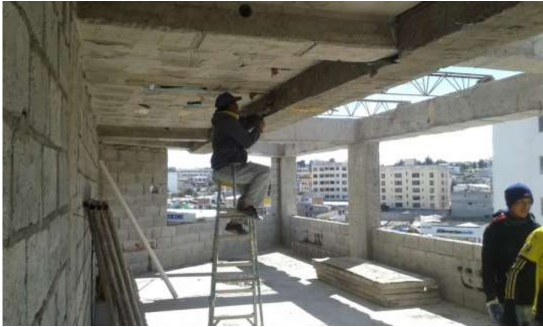
FOTOGRAFIA N° 12: Hombre Albañil realizando tareas de picado en viga (albañilería) Foto tomada por: William Jácome Terán
