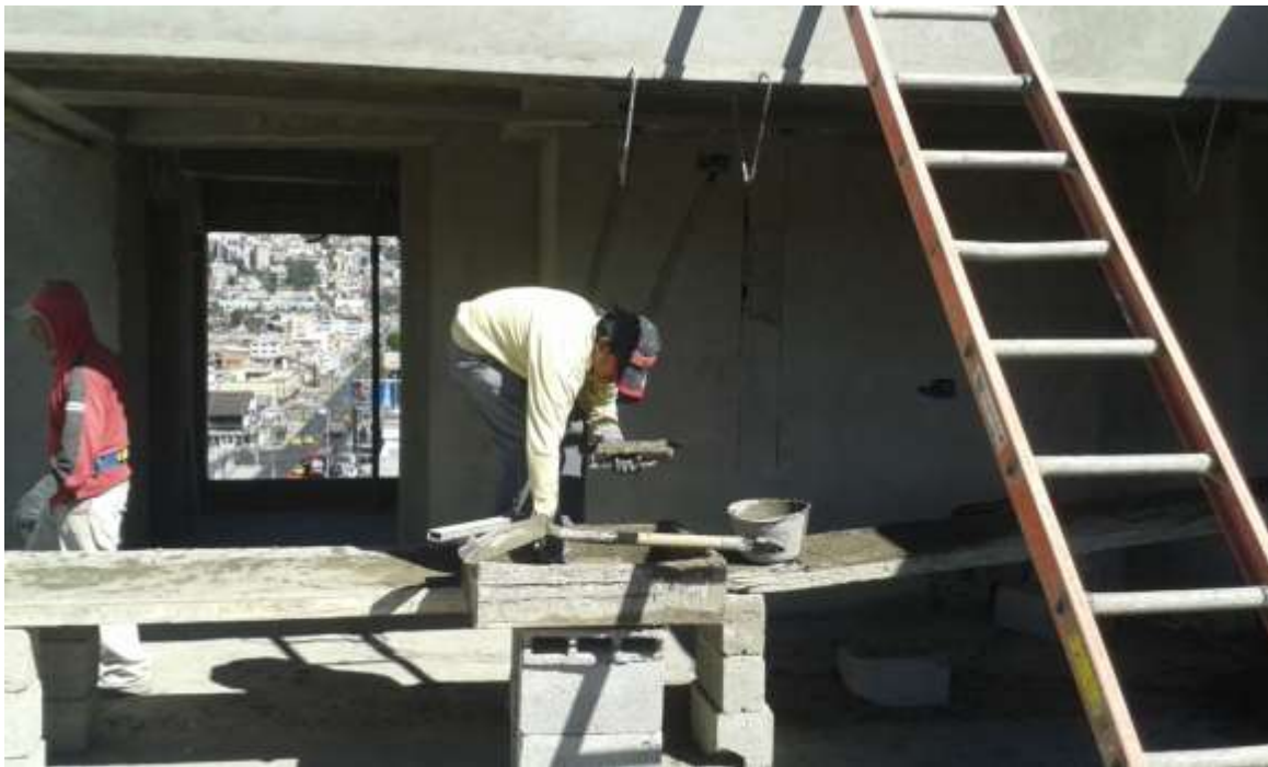
FOTOGRAFIA N° 5: Hombre Albañil realizando tareas de enlucido (albañilería) en el exterior. Foto tomada por: William Jácome Terán
