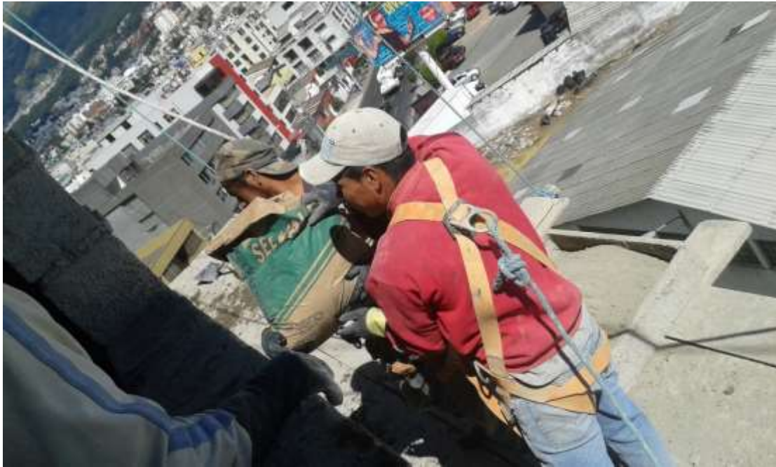
FOTOGRAFIA N° 6: Hombre Albañil realizando tareas de enlucido (albañilería) en el exterior: fachada Foto tomada por: William Jácome Terán
