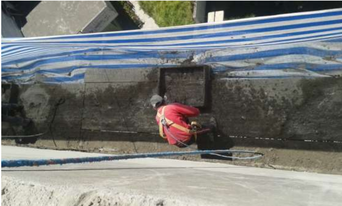
FOTOGRAFIA N° 10: Hombre Albañil realizando tareas de enlucido en exterior y en altura (albañilería) Foto tomada por: William Jácome Terán
