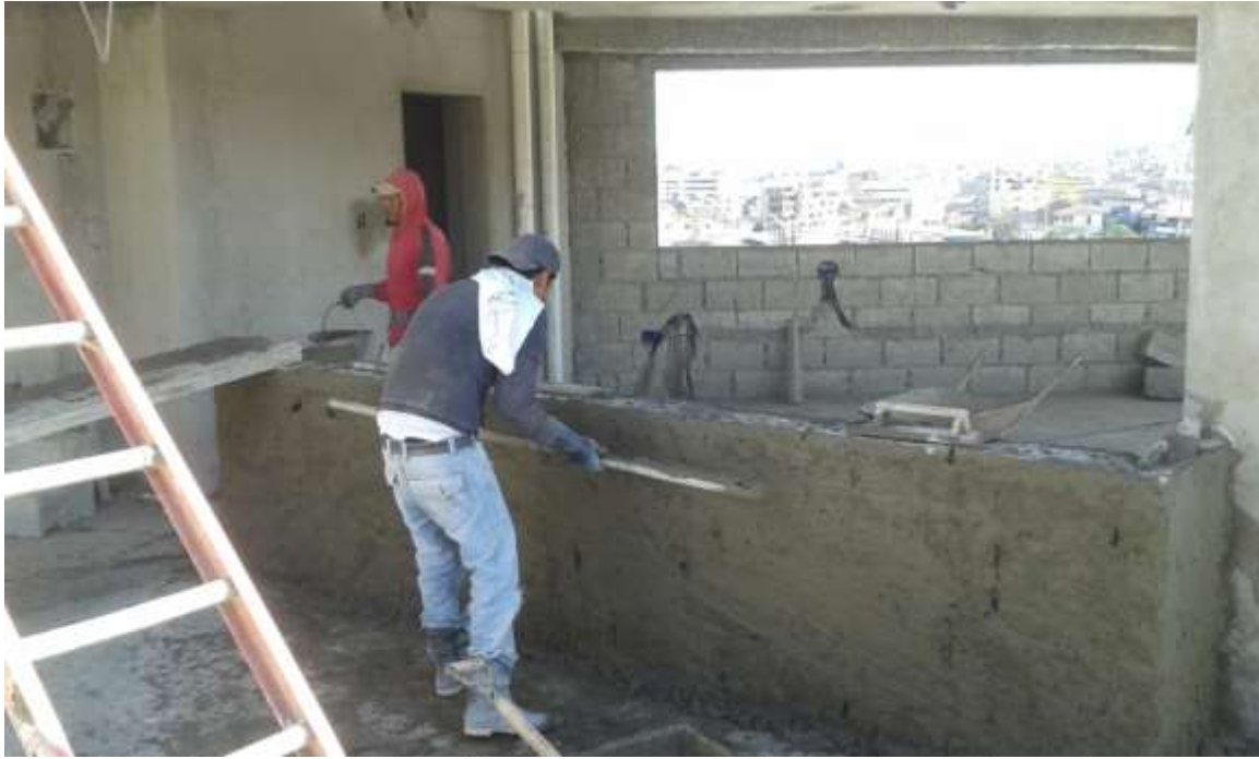
FOTOGRAFIA N° 4: Hombre Albañil realizando tareas de enlucido (albañilería) Foto tomada por: William Jácome Terán
