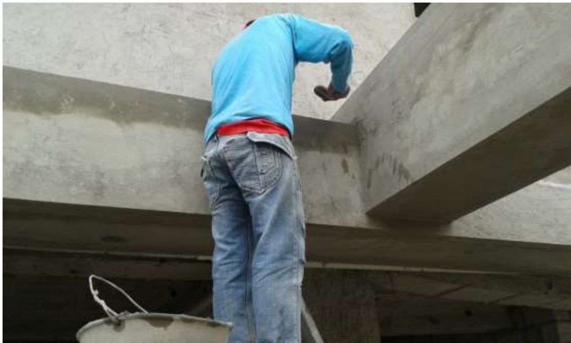
FOTOGRAFIA N° 13: Hombre Albañil realizando tareas de enlucido en fajas (albañilería) Foto tomada por: William Jácome Terán
