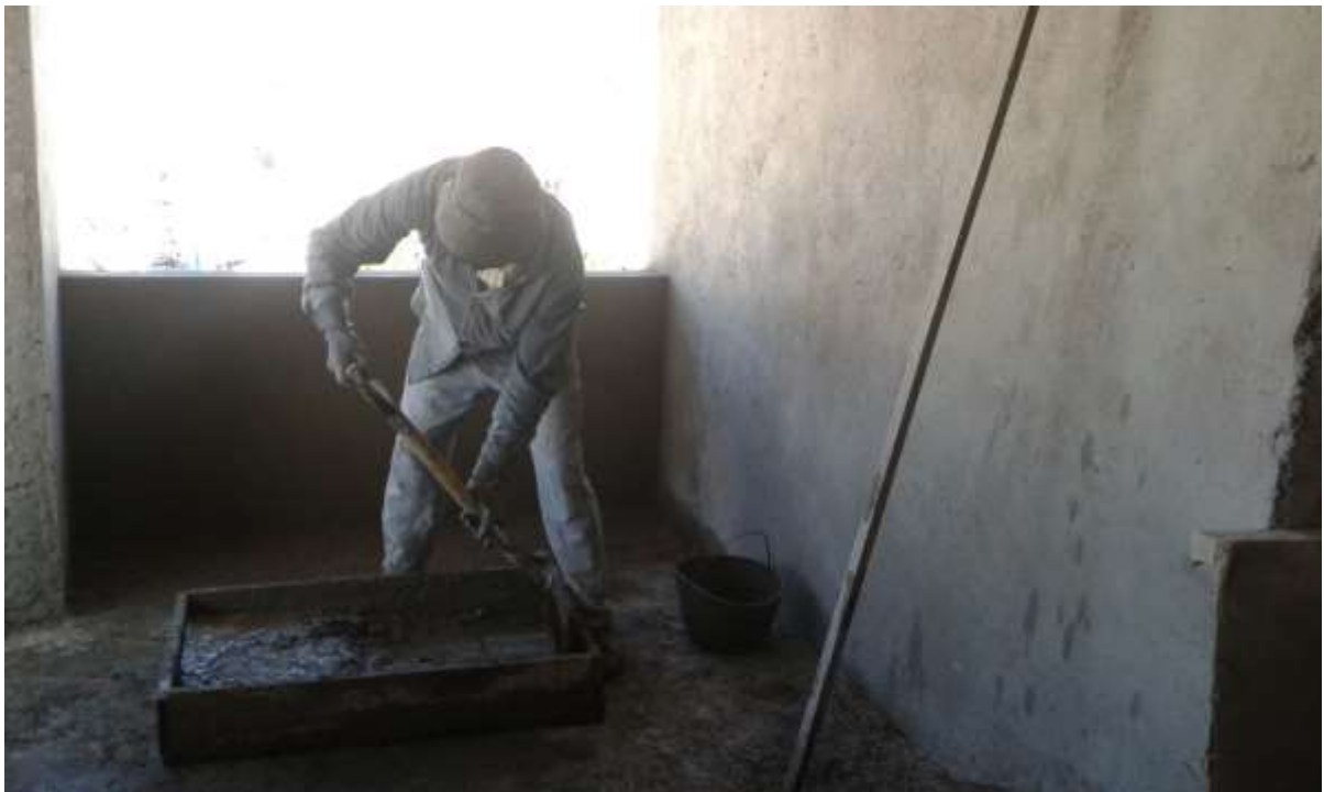
FOTOGRAFIA Nº 3: Hombre Albañil realizando tareas de enlucido (albañilería) en el interior.
