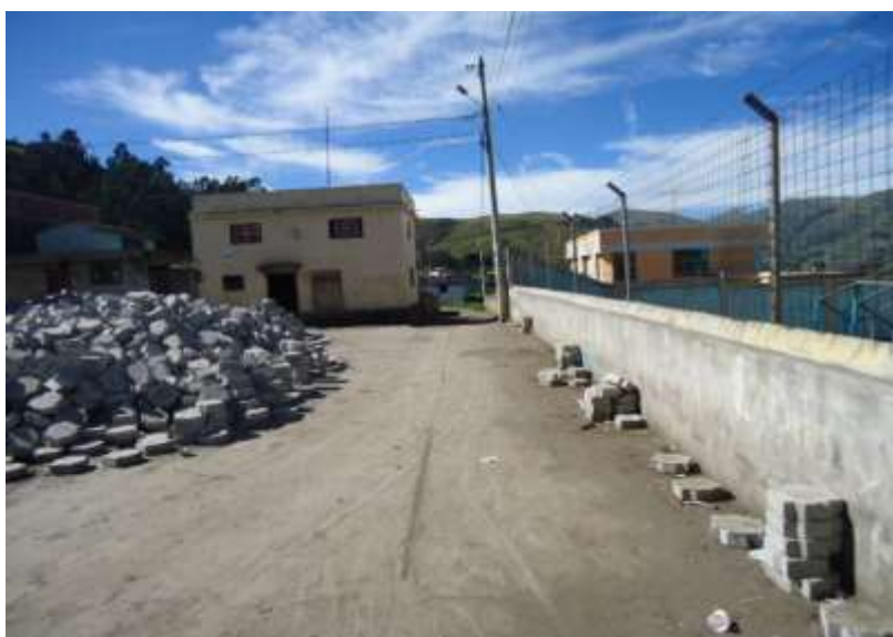
Ilustración No. 1.2: Energía Eléctrica (zona Guabug)
