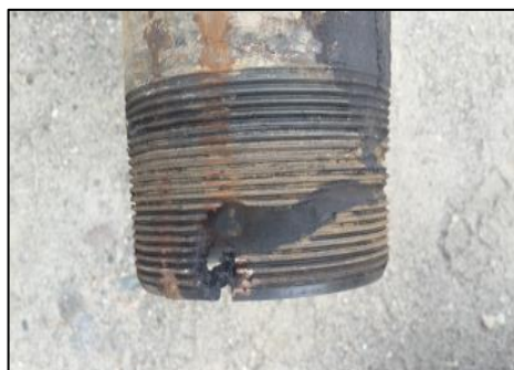
Figura 7. Corrosión por tensión
