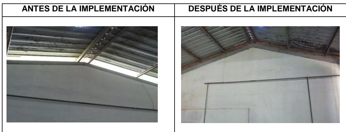
Figura 3. Unión de paredes y techo
