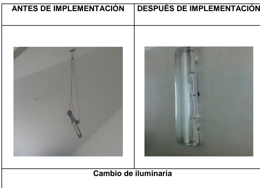
Figura 5. Implementación de nueva iluminaria y protección
