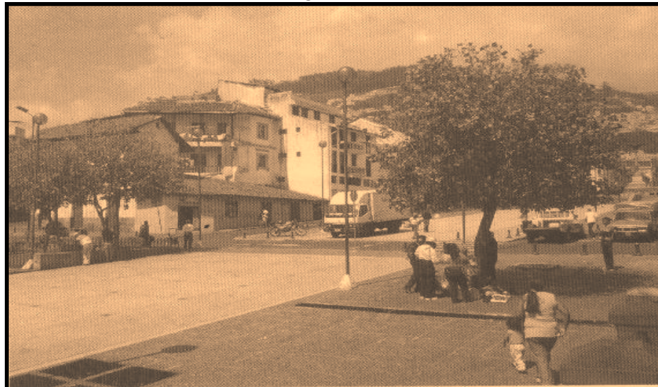
Av. 24 de Mayo Fotografía N° 45
