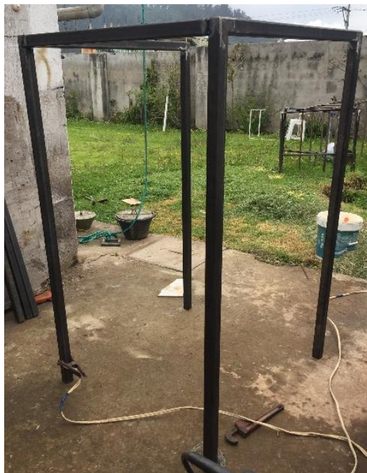
Figura 36. Aplicación de suelda
