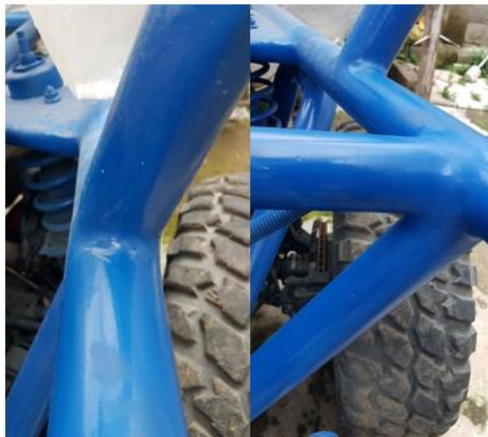
Figura 37. Inspección visual de uniones de la estructura
