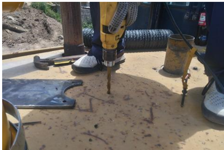
Figura 14. Perforaciones para la fijación de la base del filtro.
