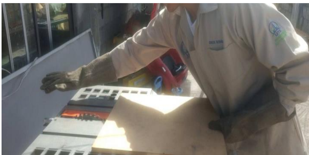
Figura 7. Corte de la madera para la estructura
