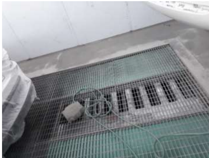
Figura 8. Estado de cabinas de pintura.
