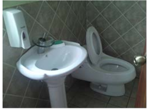
Ilustración 35 Baño Gerencia de Refinación
