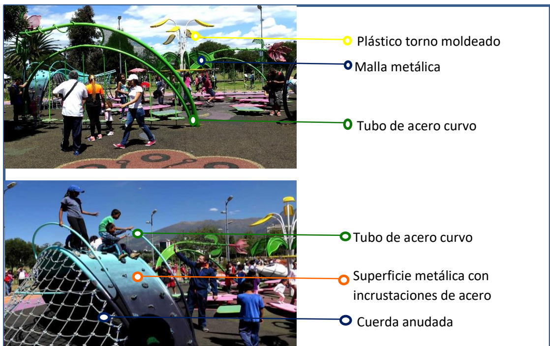
Ilustración 33. Identificación de Materiales en Juegos Infantiles Fuente: Elaboración propia basada en los juegos infantiles del área de juegos flor de taxo
