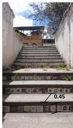
FIGURA 111 Escaleras de acceso no Ergonómicas para todo tipo de usuarios. FUENTE: Anahí Barros
