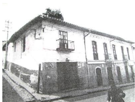
FIGURA 12 Fachada de la Casa del siglo VII, en la calle Rocafuerte y Quiroga. FUENTE: Roberto Andrade “Centro histórico de Quito”
