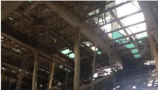
FIGURA 113 Carrizo en deterioro (presencia de humedad, hongos y astillamiento en vigas de madera) Estilo colonial. FUENTE: Anahí Barros
