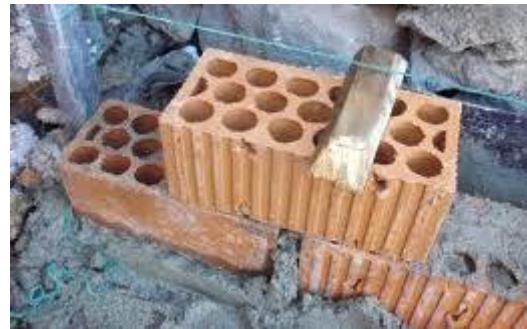
DESCRIPCION: Alineación de ladrillos.
