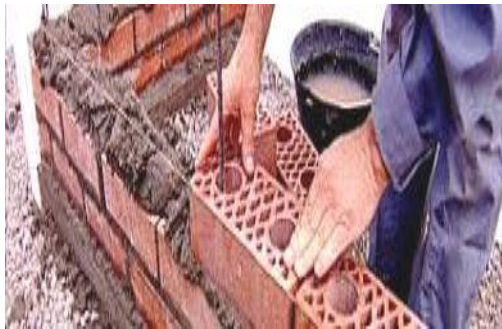
DESCRIPCION: Colocación de hileras de ladrillo. FUENTE: elmaestrodecasas.blogspot.com
