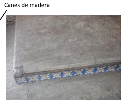
FIGURA 115 Baldosas descoloridas FUENTE: Anahí Barros
