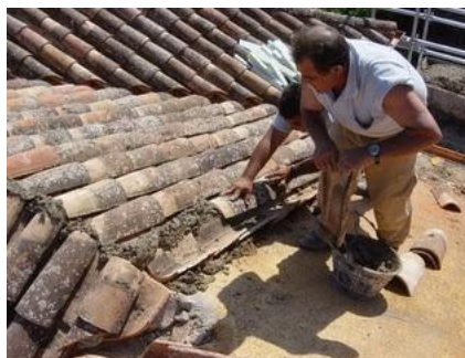
FIGURA 39 Colocación manual de tejas españolas Sobre cubiertas coloniales antiguas. FUENTE: elmaestrodecasas.com
