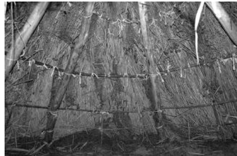
FIGURA 18 Vista Interior de la cubierta de una Choza primitiva. FUENTE: objetivosilvania.blogspot.com
