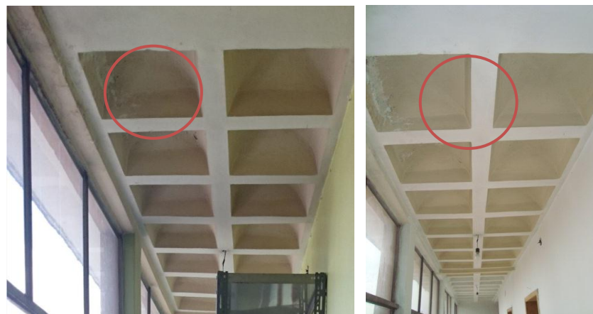
Imagen 23. Losa bidireccional con alivianamiento. (Antes- después)
