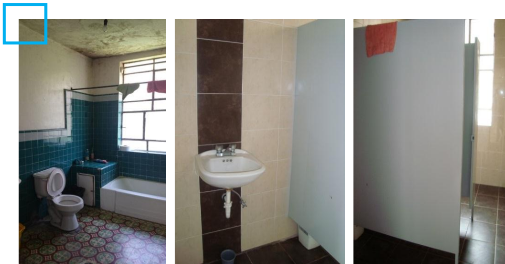
Imagen 21. Intervenciones en Baño Primera Planta Alta (Antes- después)
