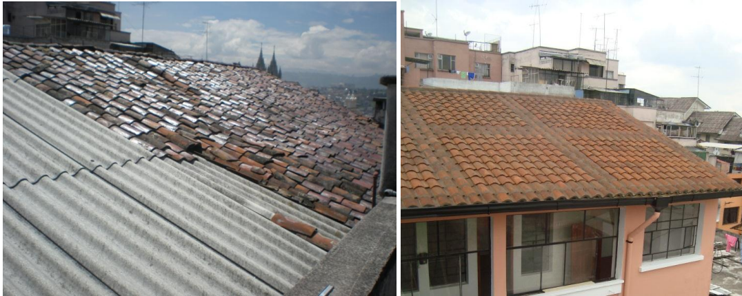
Imagen 25. Intervención Exterior Tejas Cubierta (Antes- Después)
