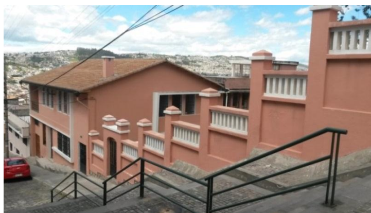
Imagen 11. Cerramiento Casa Galápagos
