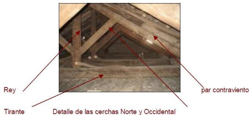
Gráfico 9. Diseño Estructuras Cerchas de madera
