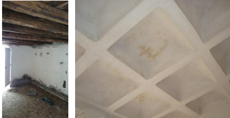
Imagen 4. Cielo Raso- Losa nervada Primera Planta Alta.
