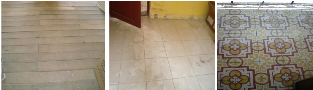
Imagen 3. Pisos y entrepisos Casa Galápagos.
