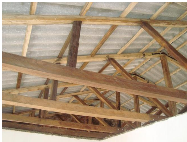
Imagen 5. Cubierta Primera Planta Alta Casa Galápagos
