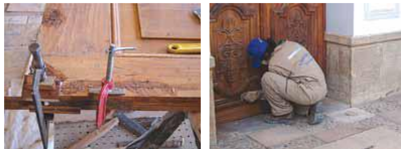
Gráfico 49: Consolidación y rehidratación de puertas de madera.
