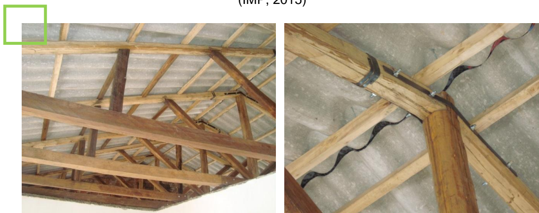
Imagen 24. Intervención Cubierta de madera (Primera Planta Alta)
