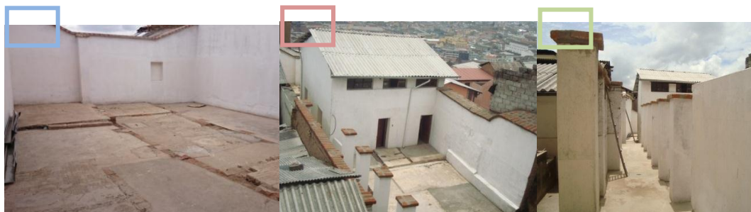
Imagen 18. Departamentos lado Este Casa Galápagos. (Estado Actual) (ARIAS, octubre 2015)
