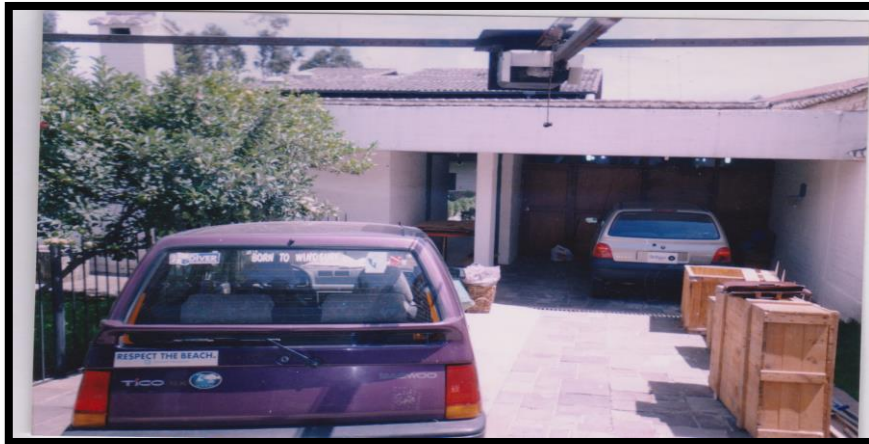
Imagen 9 Fachada frontal. Planta baja Fuente: Investigación de campo Autoría: Fotografía Propia
