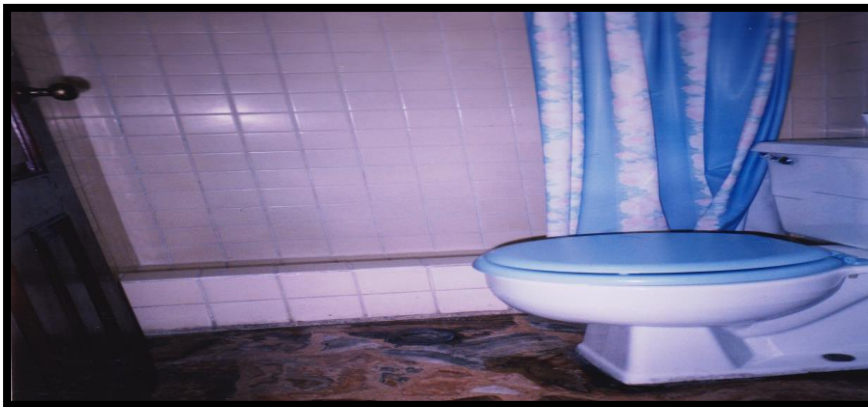
Imagen 7 Cuarto de servicio. Planta baja Fuente: Investigación de campo Autoría: Fotografía Propia
