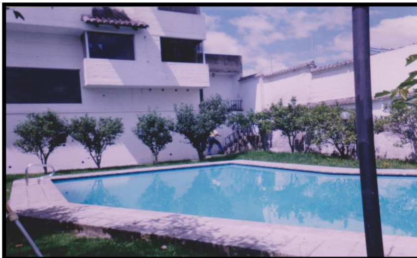
Imagen 20 Piscina Fuente: Investigación de campo Autoría: Fotografía Propia
