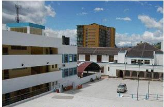
Imagen 69. Fuente: Instalaciones Antiguas www.infinittone.com
