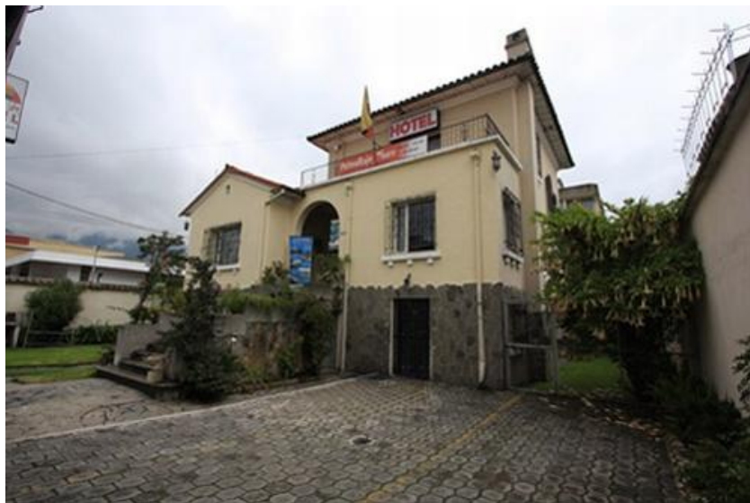
Fotografía 1. Fachada Traveller's Inn Hotel Fuente: Archivo Fotográfico Traveller's inn
