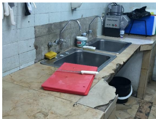
Ilustración 2.- Lavabos y paredes
