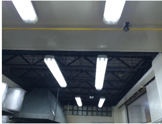
Ilustración 1.- Techo cafetería Eqalbe
