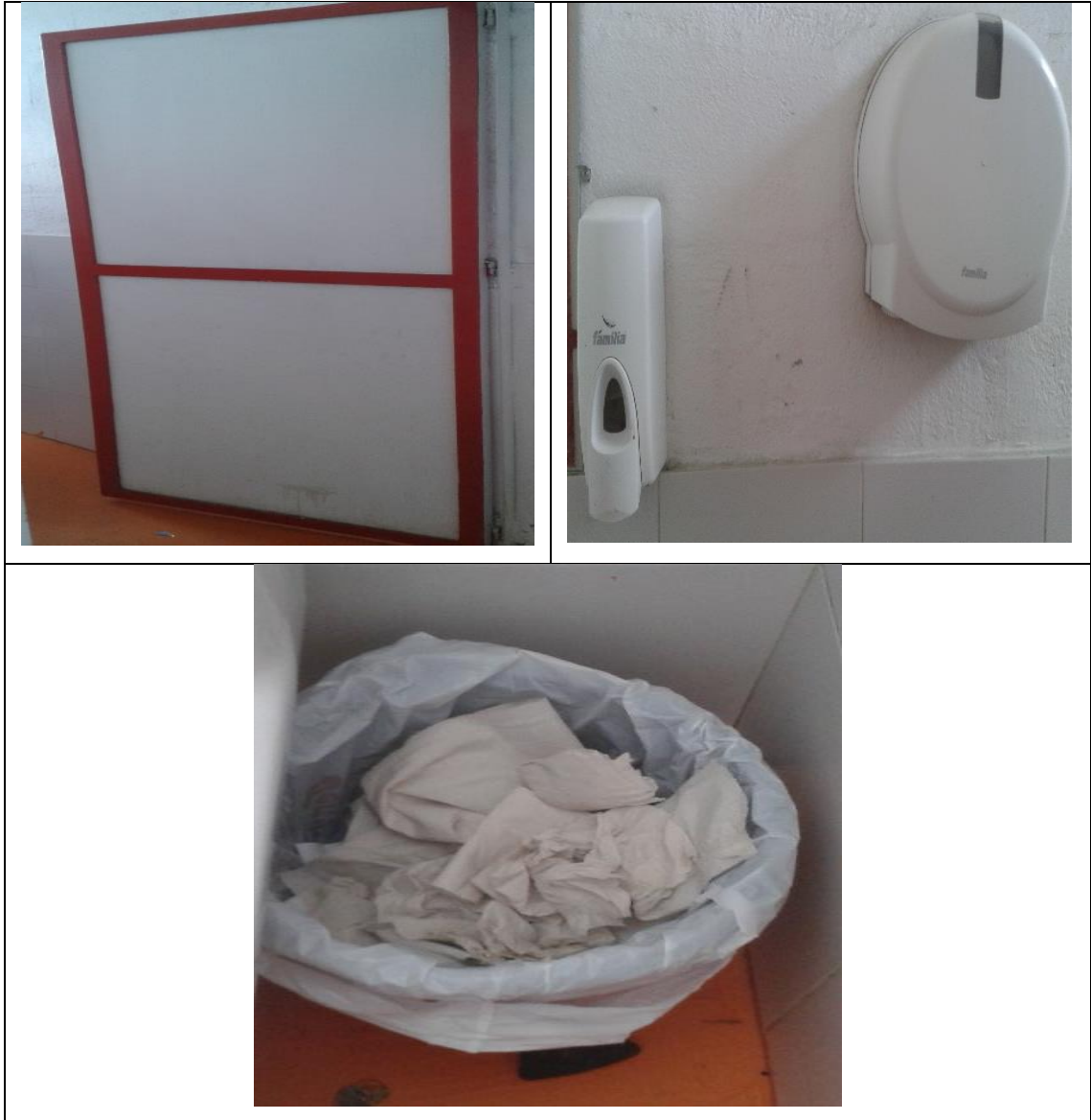
Figura 9: Área de Servicios Sanitarios.
