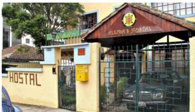
Foto 9: Fachada Hostal Aleida's Fuente: Autor
