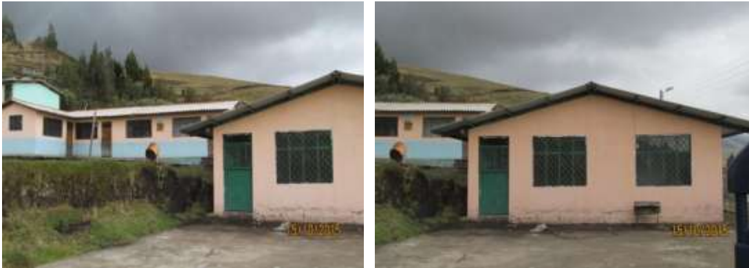
Fotografía 1. Casa comunal de Chumillos Central Fuente: La Autora
